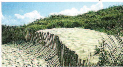
Travaux de restauration de la dune.
