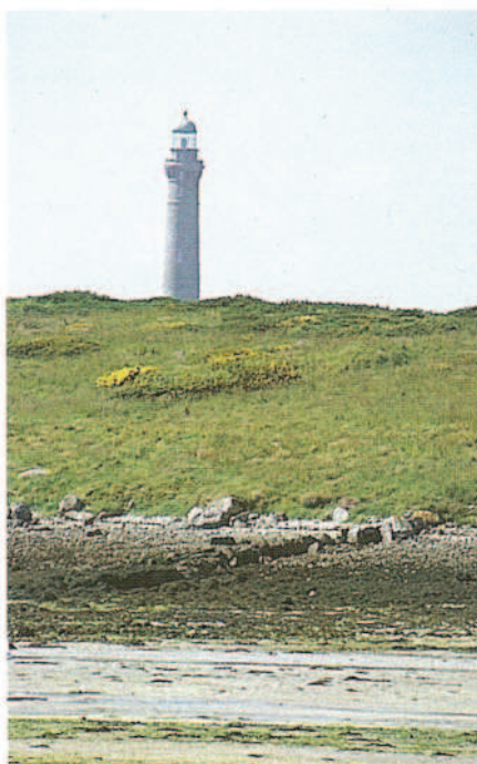
Enez Venan. Ancien quai de déchargement des bateaux goémoniers.
